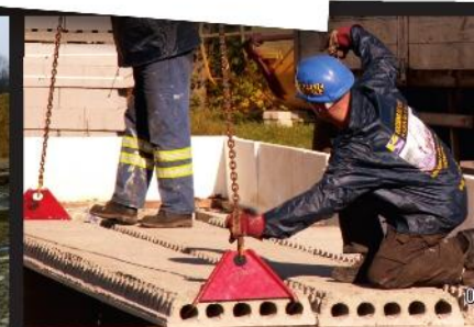
DOLNA WARSTWA GŁADKA - NIE WYMAGA TYNKOWANIA
