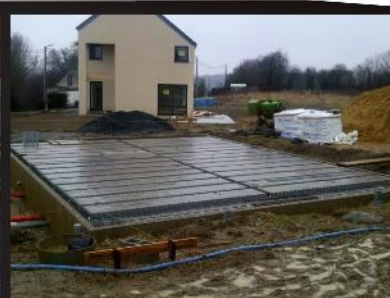
DOLNA WARSTWA GŁADKA - NIE WYMAGA TYNKOWANIA
