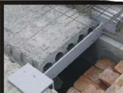
DOLNA WARSTWA GŁADKA - NIE WYMAGA TYNKOWANIA
