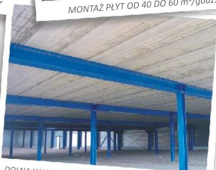
DOLNA WARSTWA GŁADKA - NIE WYMAGA TYNKOWANIA
